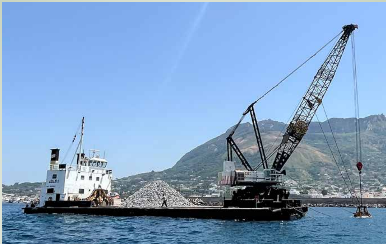
Preparazione scanno di imbasamento per posa Moduli piramidali
