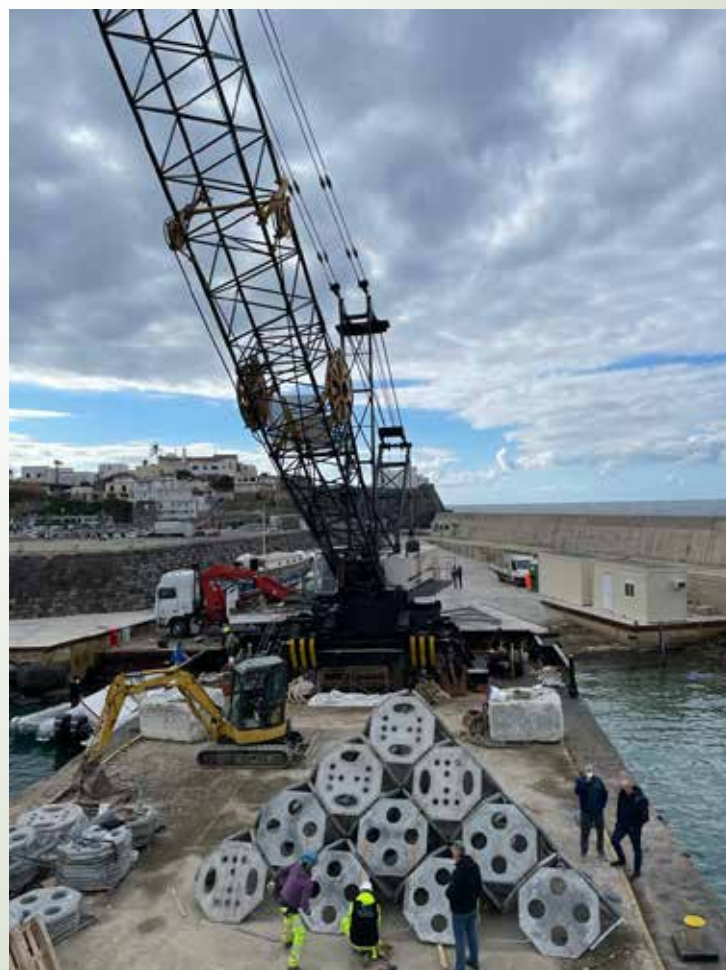
Costruzione Moduli piramidali su pontone
